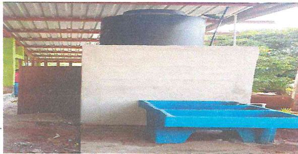
Foto 3: Sustitución de pila para uso de la cocina.
