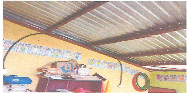
Foto 2: Reparación de cableado eléctrico.
