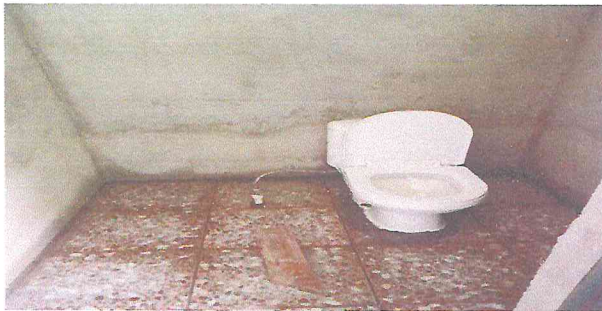
Foto1: Sustitución de sanitario y sus accesorios.
