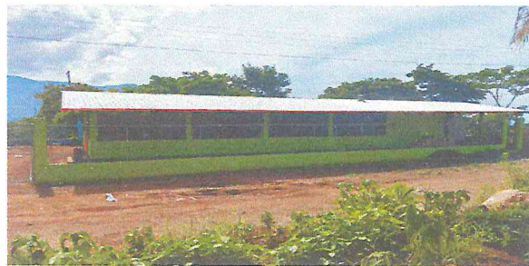
Foto 5: Sustitución de lámina troquelada en los módulos de las aulas.
