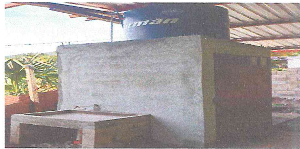
Foto 6: Sustitución de depósito de agua de 750 lts.
